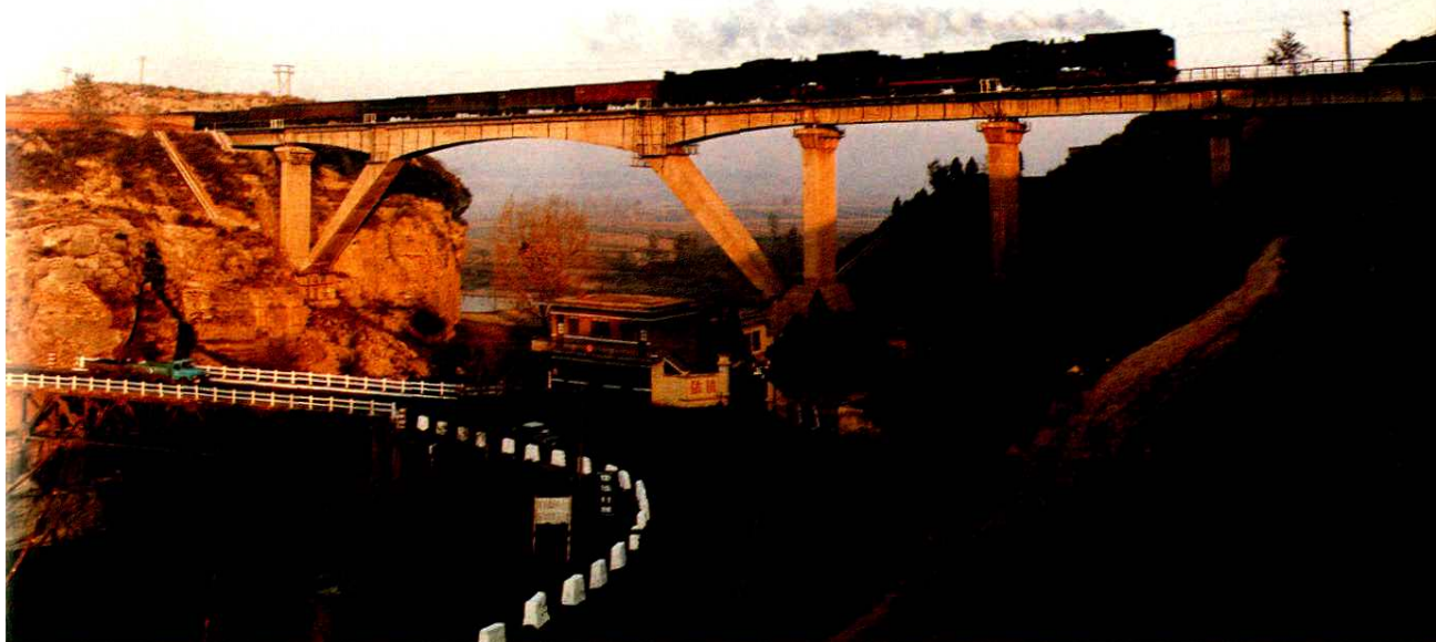
石梁铁路大桥
