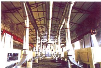
招商引资新建的棉花加工厂生产车间一角
