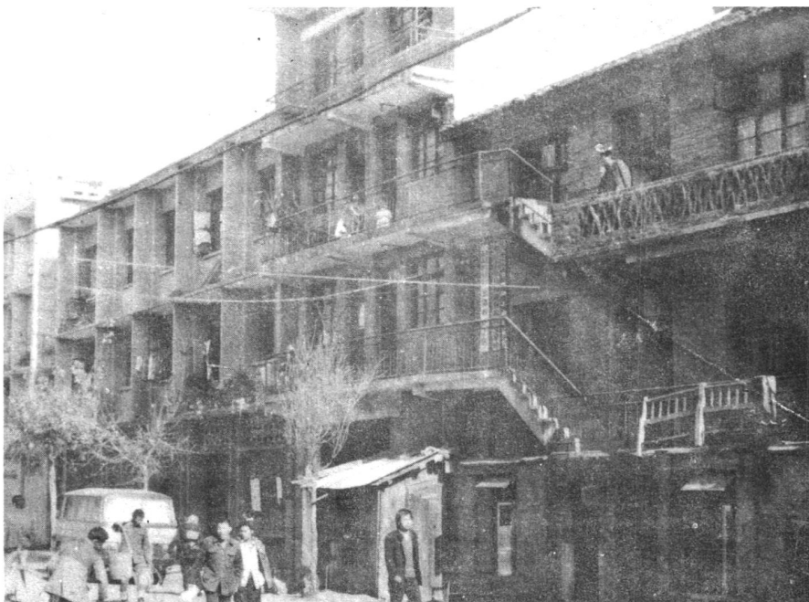
交通局办公楼
