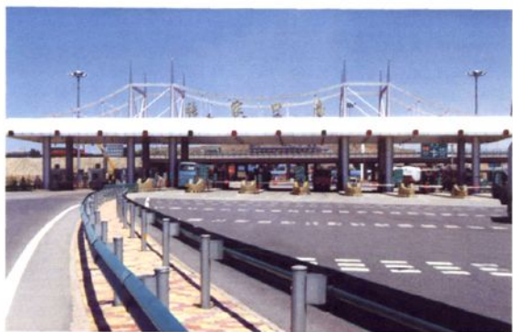
张石高速公路张家口南出入口(万全境内)
