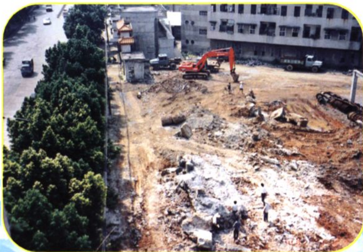
旧城区改造工程现场。
