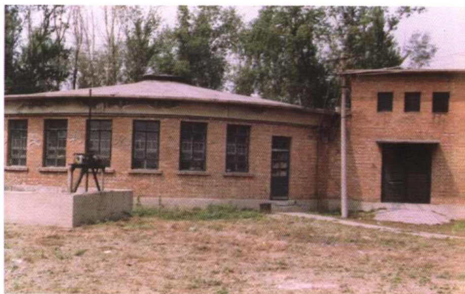
永青渠扬水站
