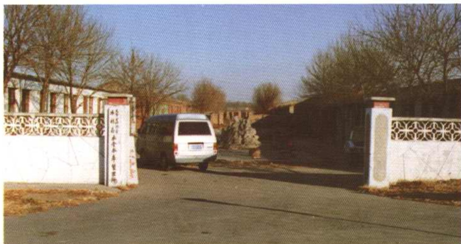
永金水库管理所
