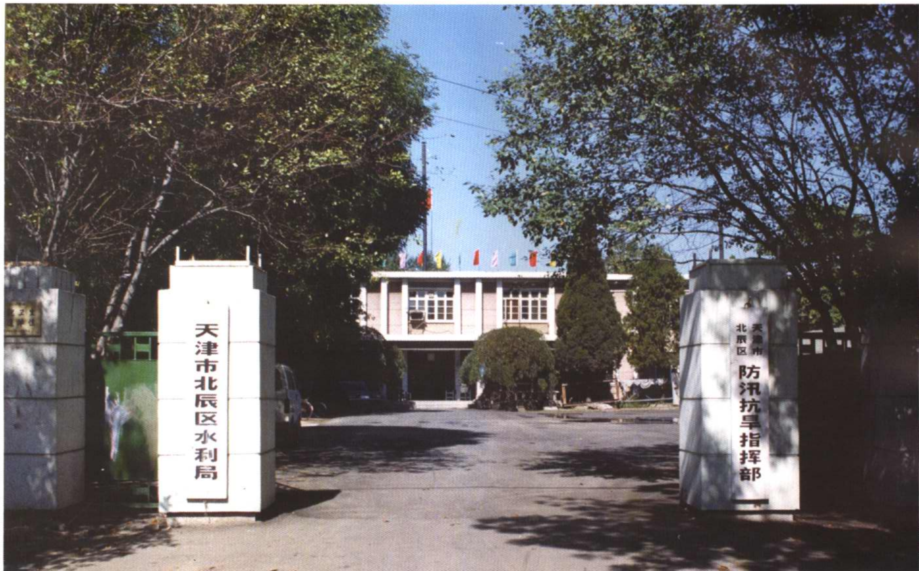
北辰区水利局办公楼
