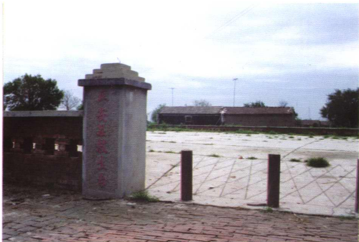
永定河泛区救生台
