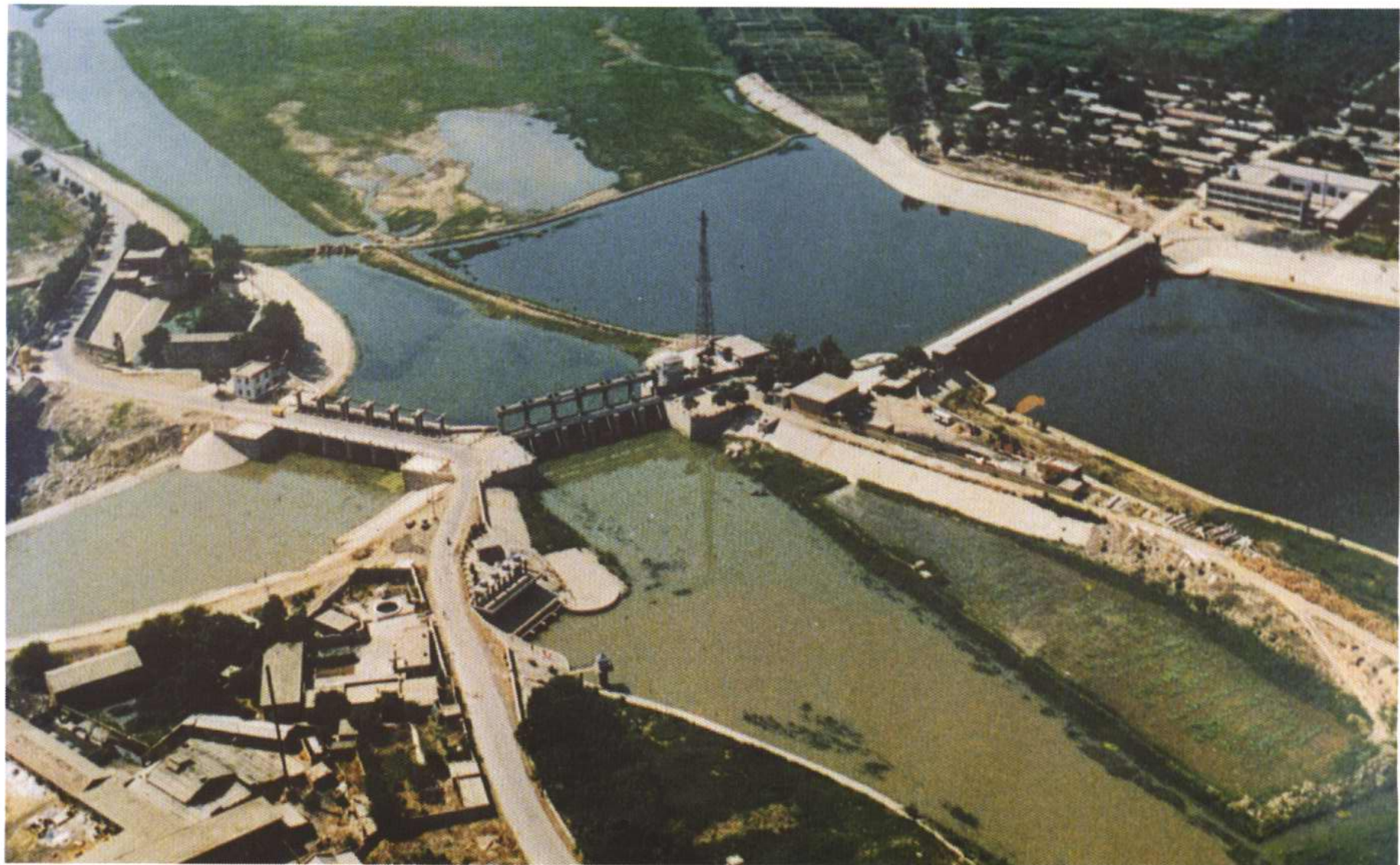
屈家店枢纽闸
