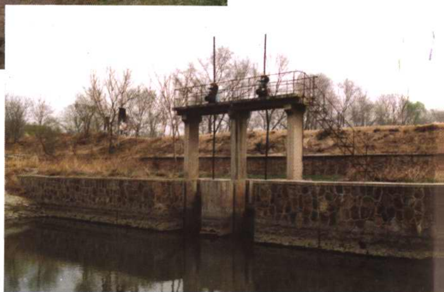
堵口堤泵站淀南引河闸
