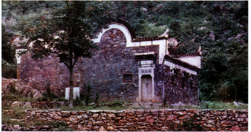
中共大冶中心县委旧址
