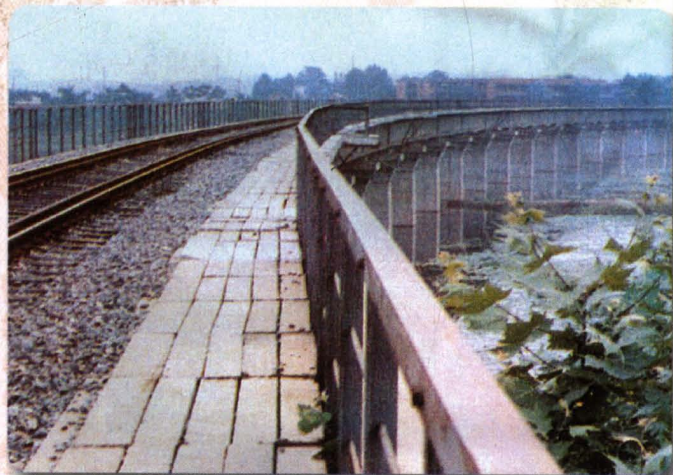
大沙铁路大冶段铁路桥
