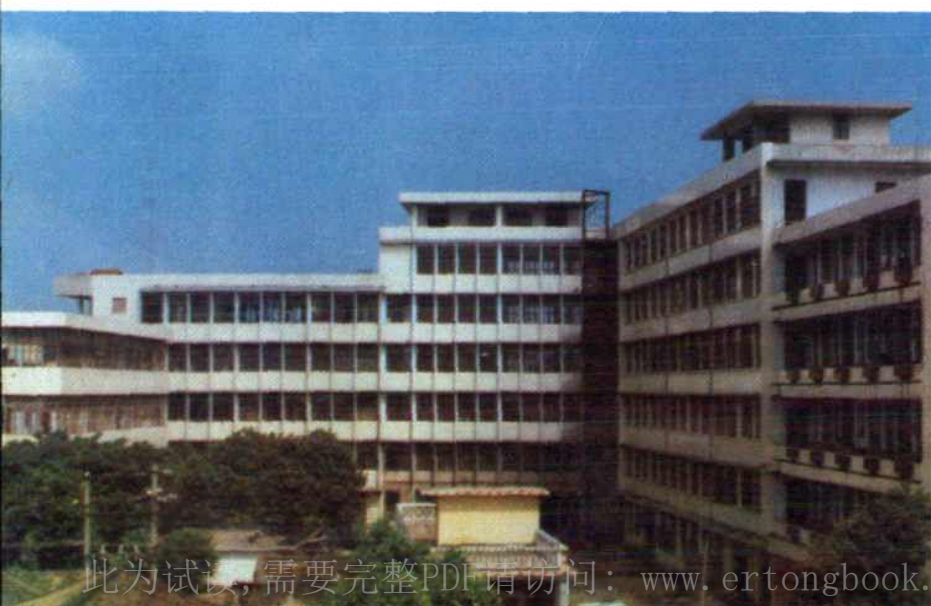
图9 泉州市甲第巷电子工业整机装配区
