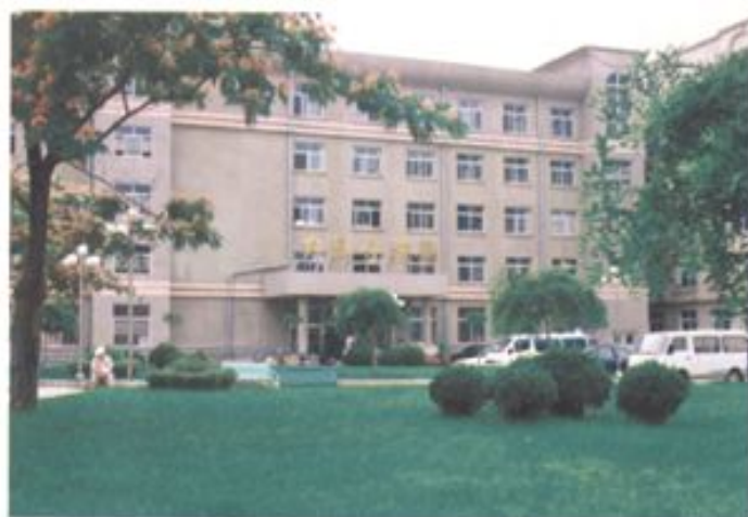
内科住院部大楼
