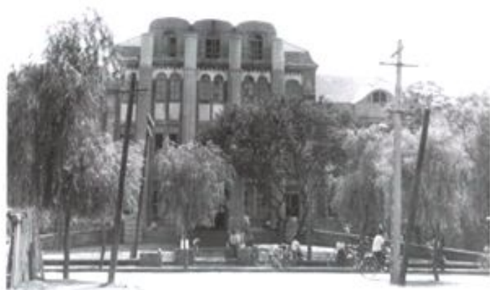
医院办公楼 先期照片
