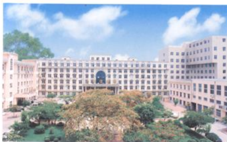
外科住院部大楼
