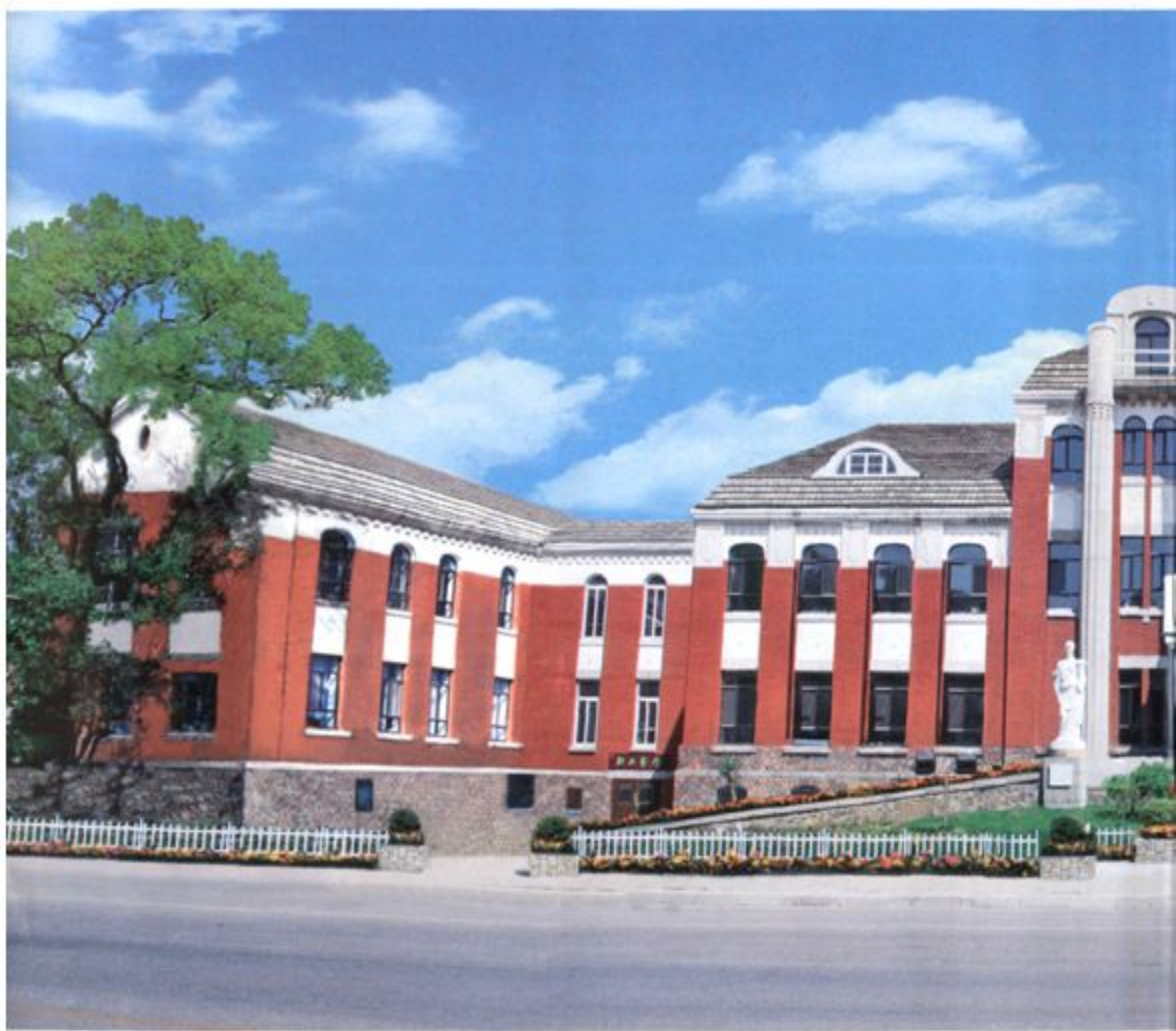
瓦房店市中心医院办公楼
