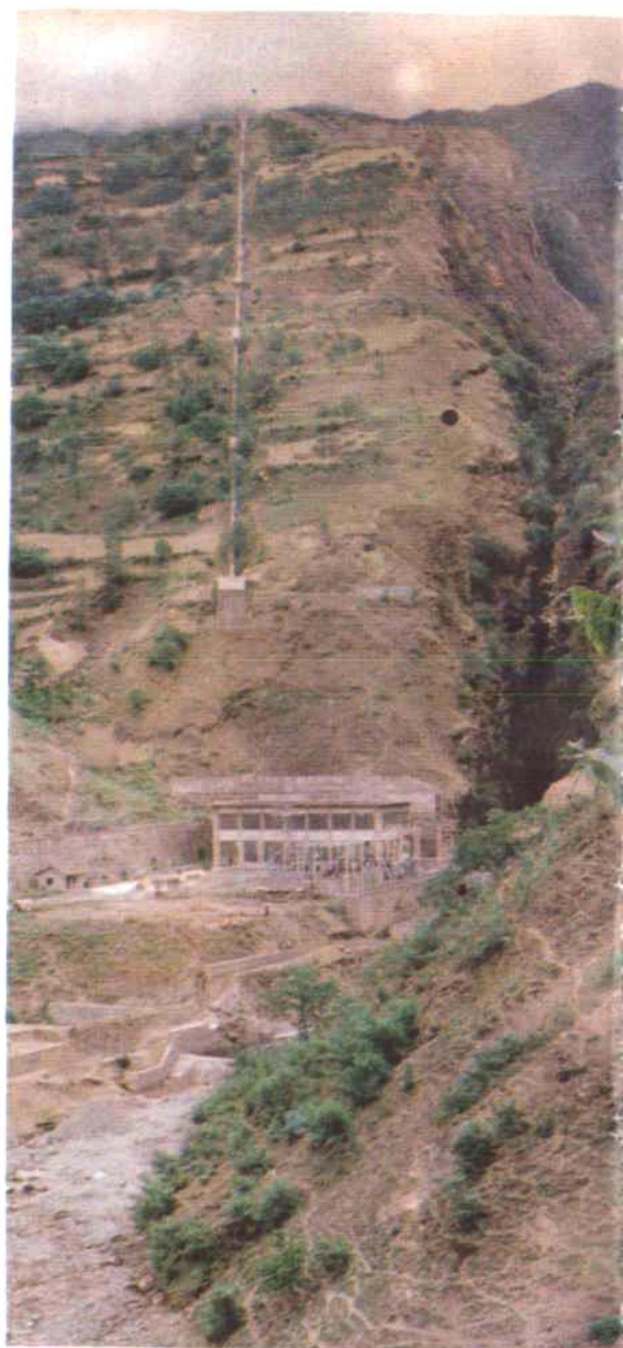
↘茫涌溪电站 2 × 2000千瓦 水轮发电机组。
