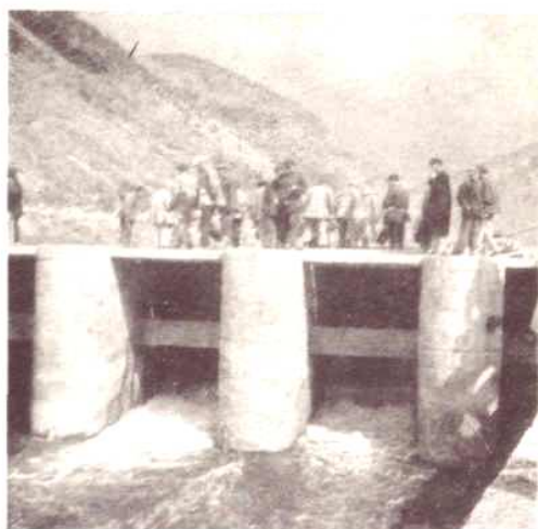
↑ 大理州委欧根等领导在 电站工地。
