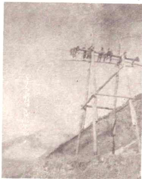
↓ 滇西第一条35千伏输电线 路于1959年建成。
