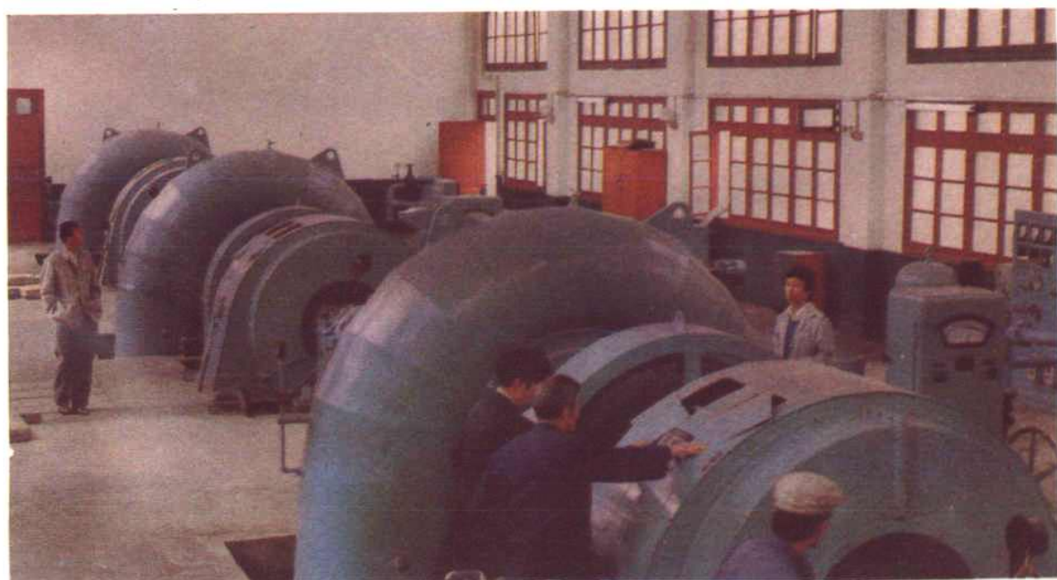
↓米子坪电站 2 \times 3000 千瓦水轮发电机组。
