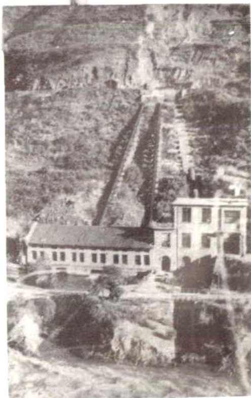
→西洱河朝地田电站。
