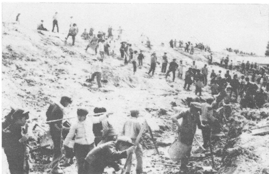
为了修好水利配套工程,农场先后修了库容 10 万立方米以上的四个大水库。这是马围水库工地一角。
