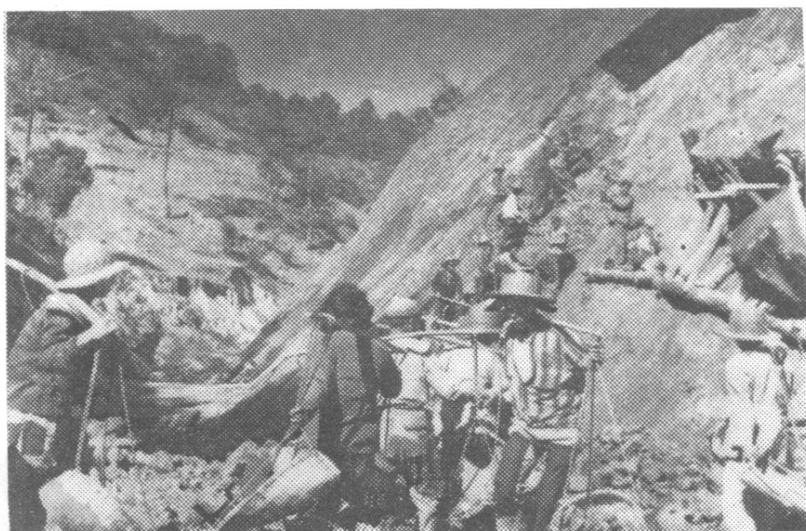
水利是农业的命脉,农场几十年坚持兴修水利。这是 1963 至 1966 年在续修红雀龙潭引水工程的打洞山涵洞。
