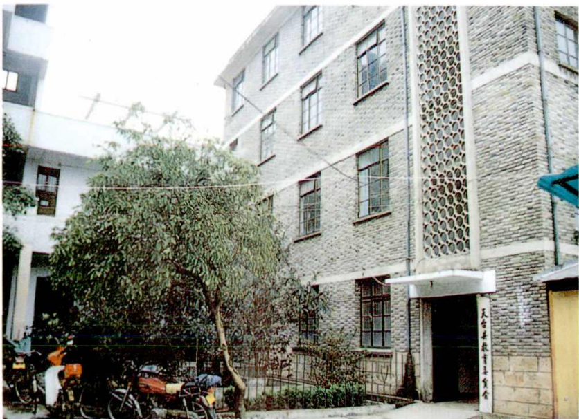
县教委办公大楼
