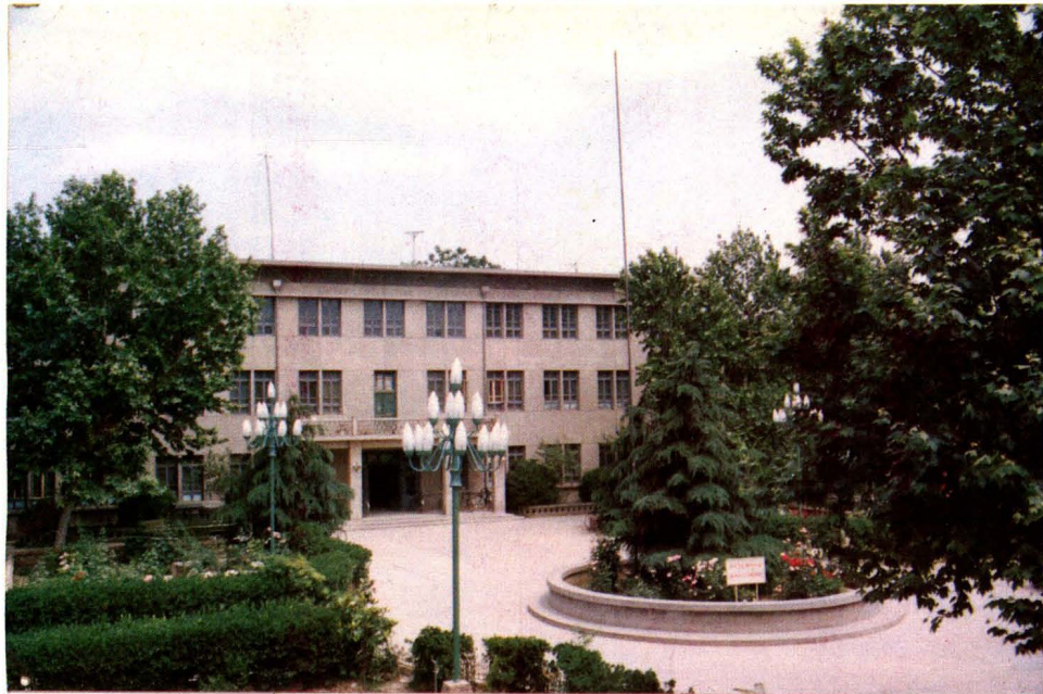
市政府办公楼
