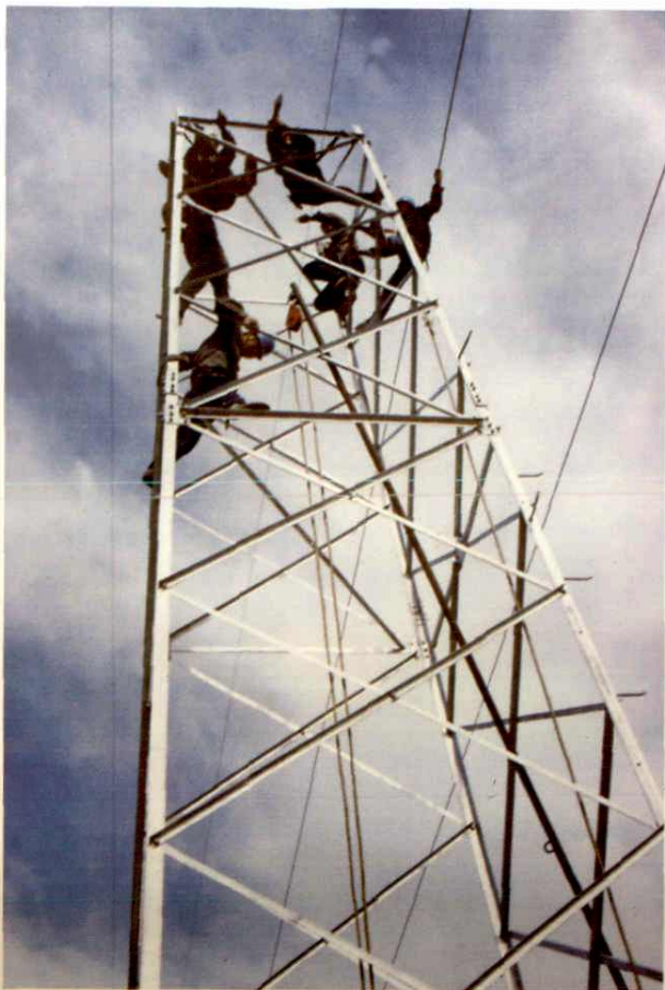
组装输电铁塔
