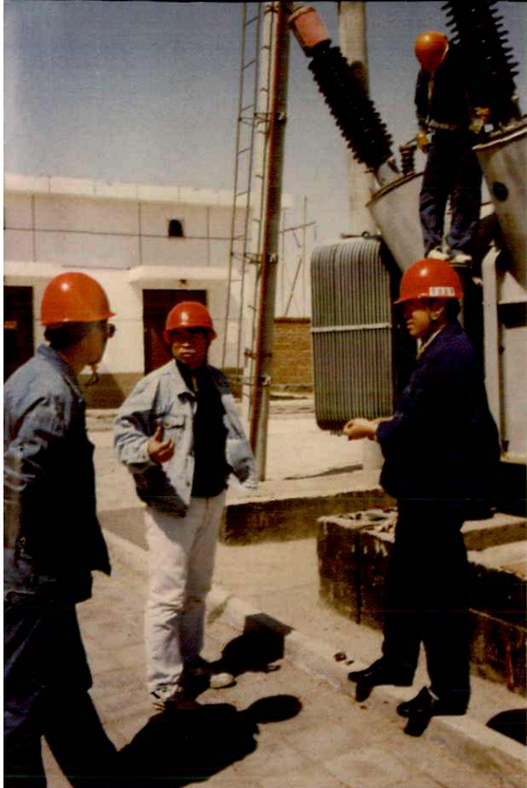
局长杨晓宪、副局长马林国在检修现场
