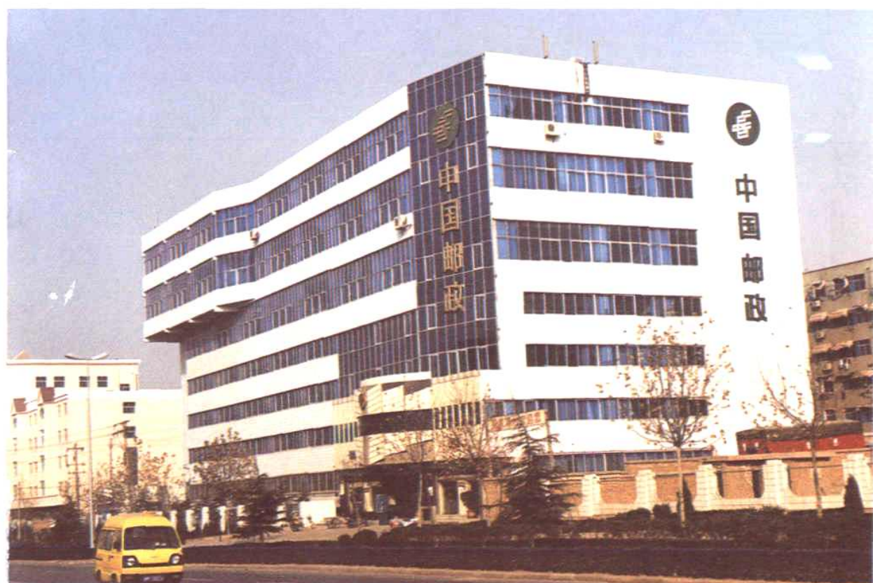
三门峡邮政大楼
