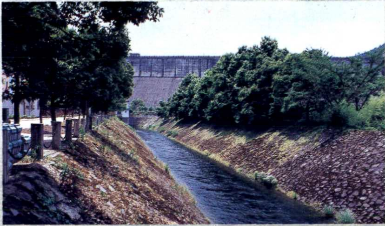
皎口水库电站尾水渠
