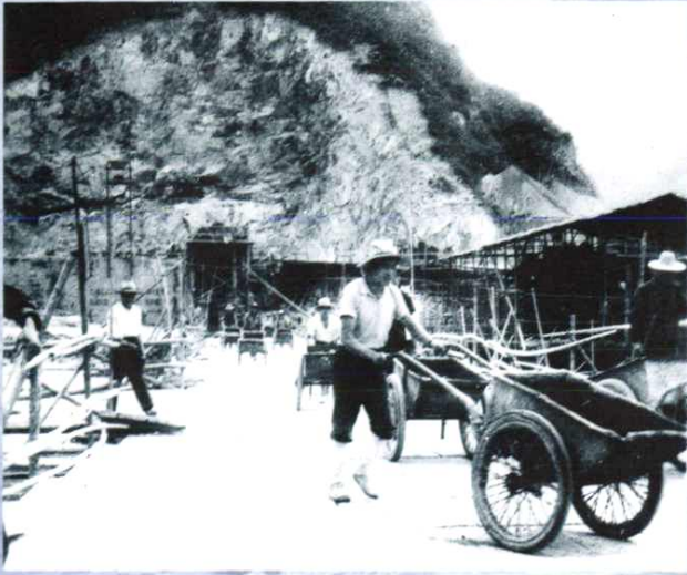
民工运送混凝土筑坝
