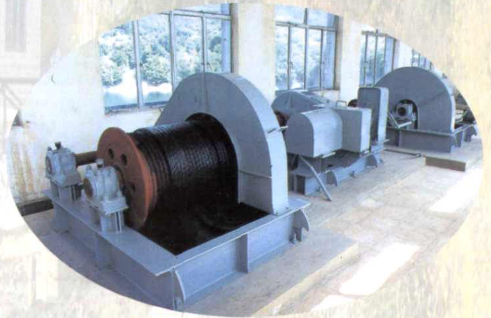
溢洪道启闭机室
