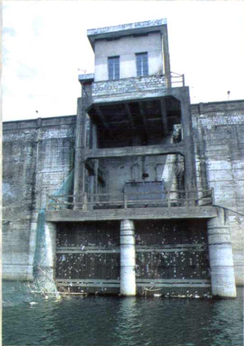
发电引水洞进口设置
