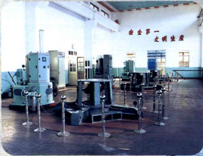
皎口电站发电机房
