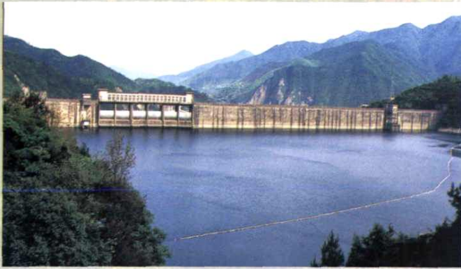
水库大坝上游面
