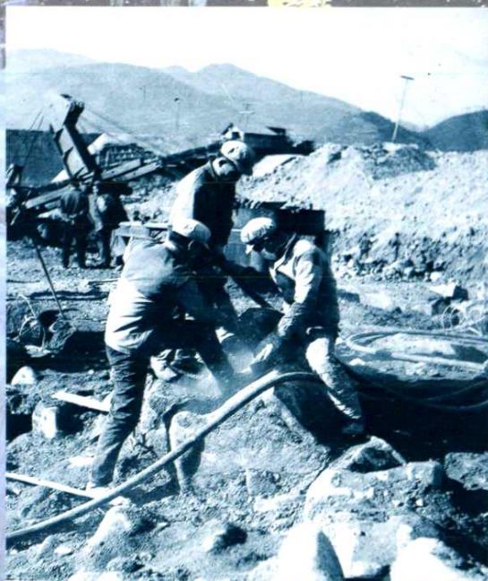
省水电工程局三处工人进行大坝基础开挖
