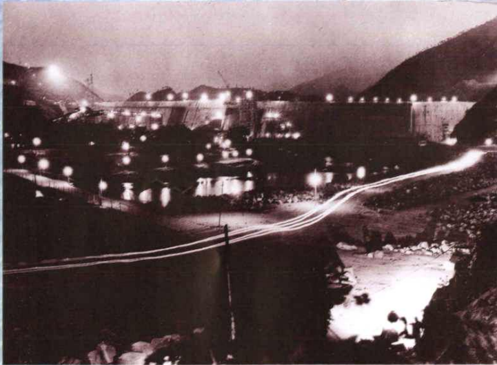
水库工地夜景
