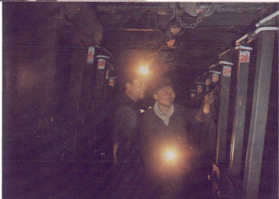
▷工程技术人员 检查工程质量
