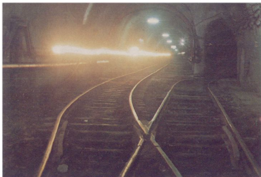
△屯头系运输巷道
