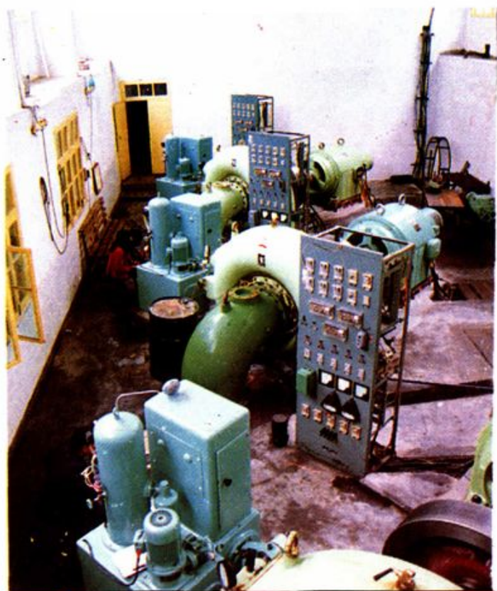
◀ 水闸电站发电机房
