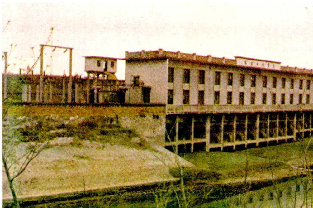
30. 曹家埝机电排灌站
