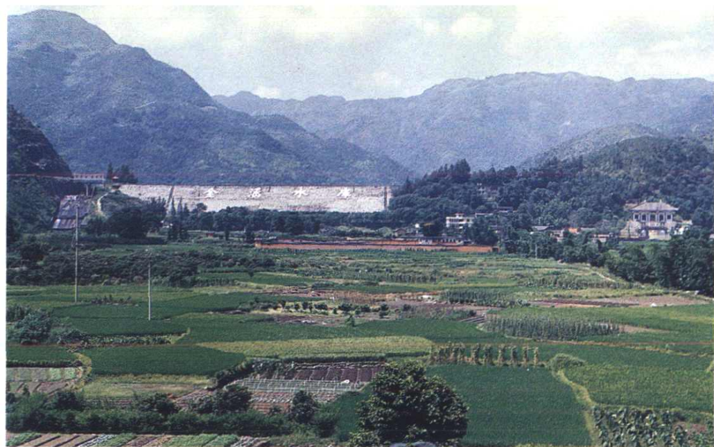
◀ 宁德金涵水库
