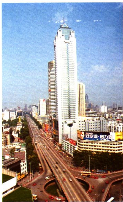
航空路立交桥
