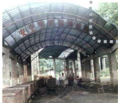
新兔煤矿斜井
