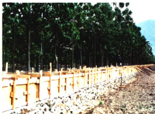
上江乡仕旺村损毁修复工程
