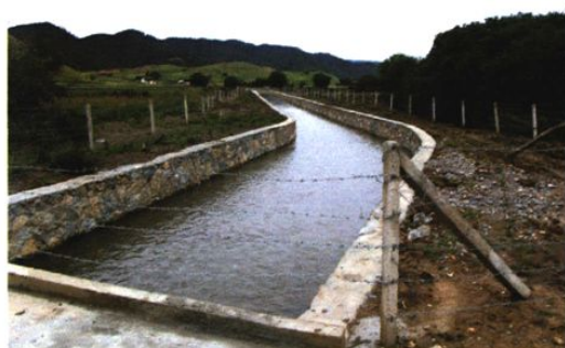
建塘镇吉迪村排涝工程
