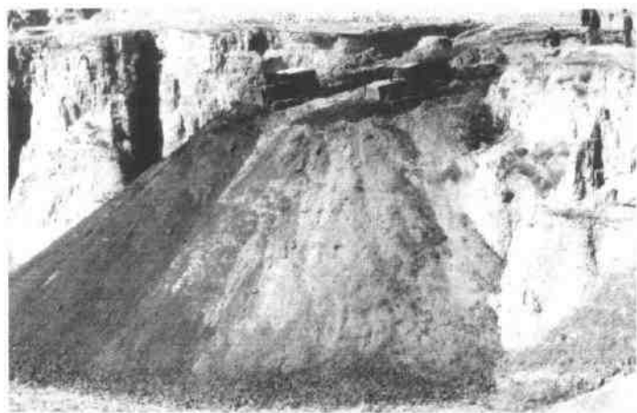
●县委县政府为优化投资硬环境，下决心进行神丰路拓宽改线。图为改线施工现场。
