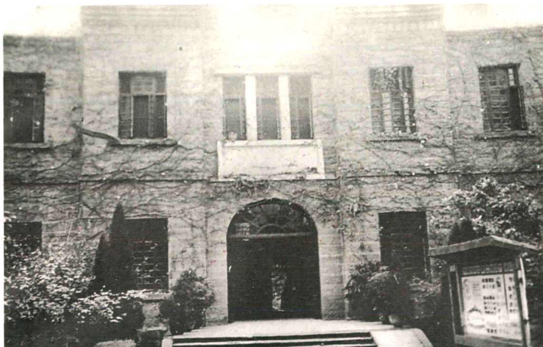
△ 四川省总工会内江地区办事处办公楼（翔龙山旧址）。
