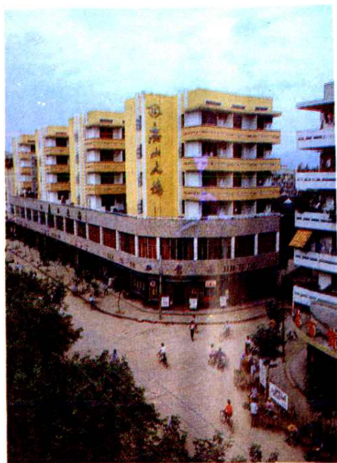
嵊县供销合作社“鹿山大楼”
