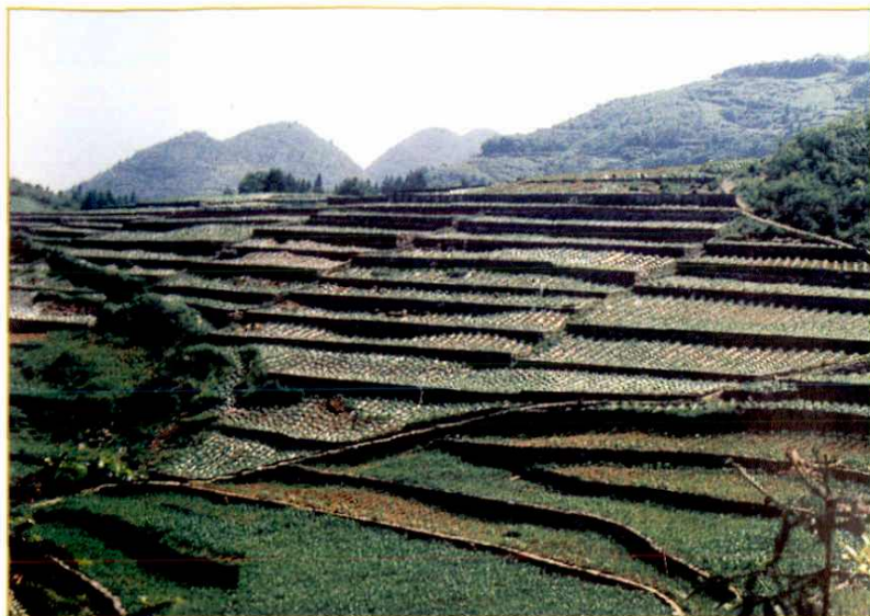
扶持农业生产，发展农村经济。 图为坡改梯工程
