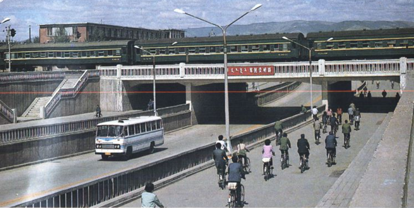
呼和浩特呼伦路立交桥
