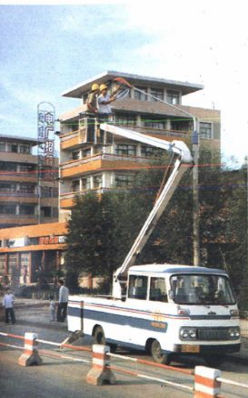
安装路灯 (通辽市)
