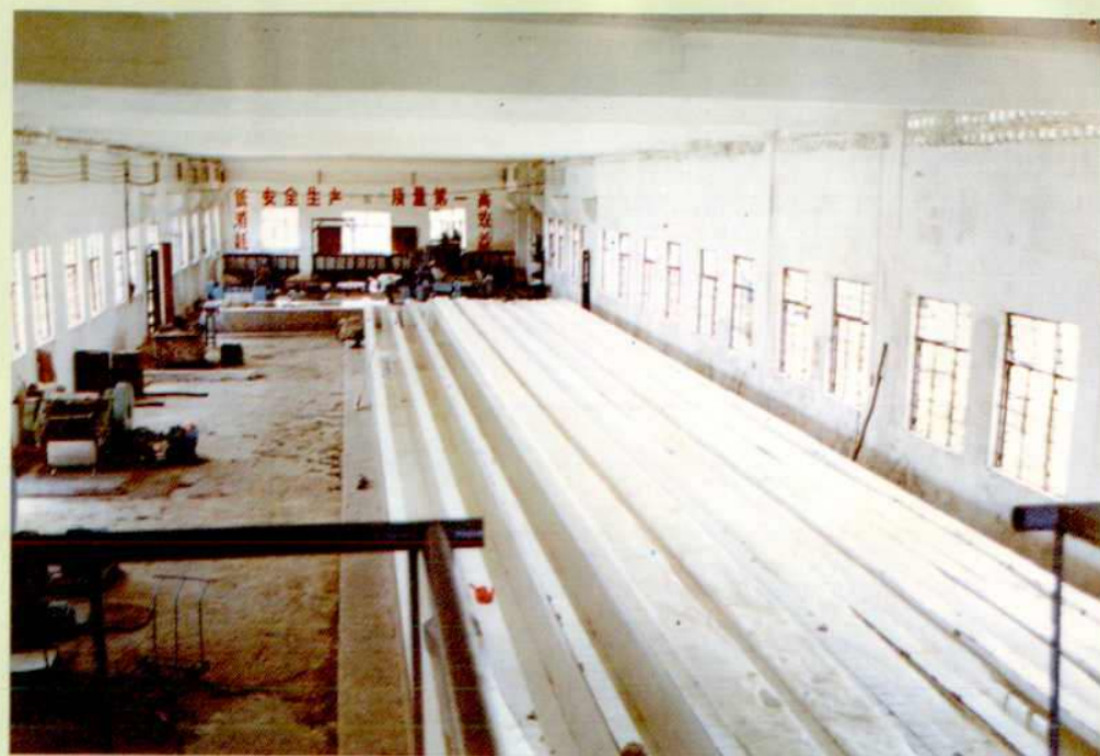
制胶厂凝固槽车间
