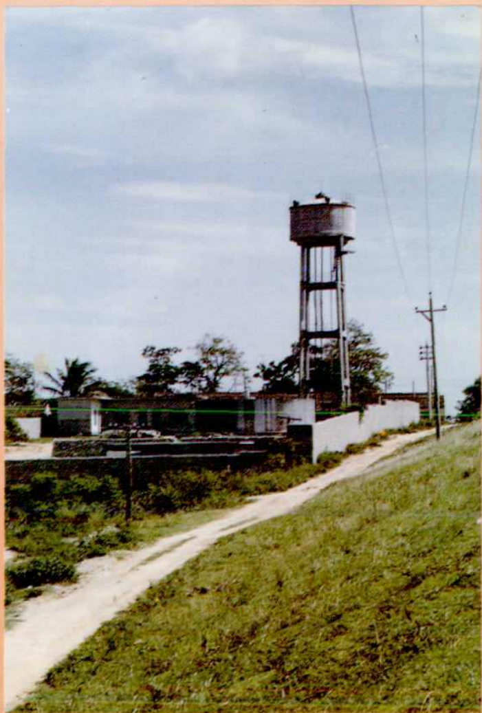
即将竣工的场部自来水厂
