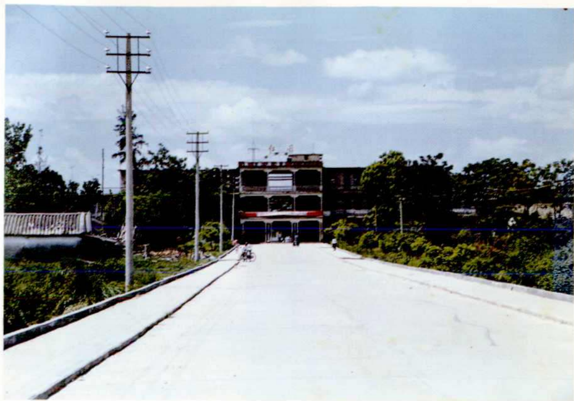
农场新建的水泥公路与办公大楼一角
