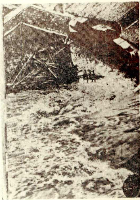
一九三五年荊州城內房屋被水冲毀情形
