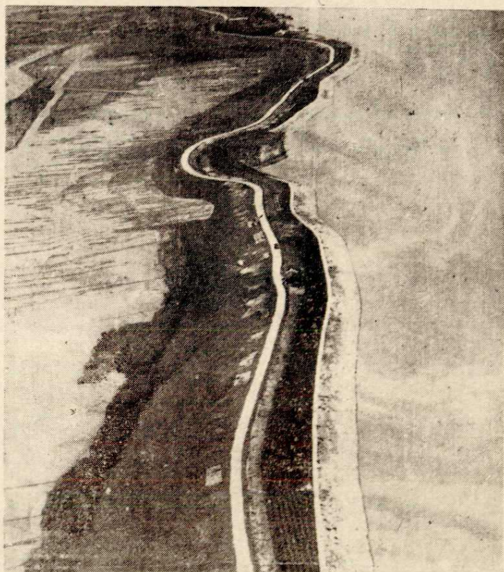
长江中游的重要防洪堤段荆江大堤
