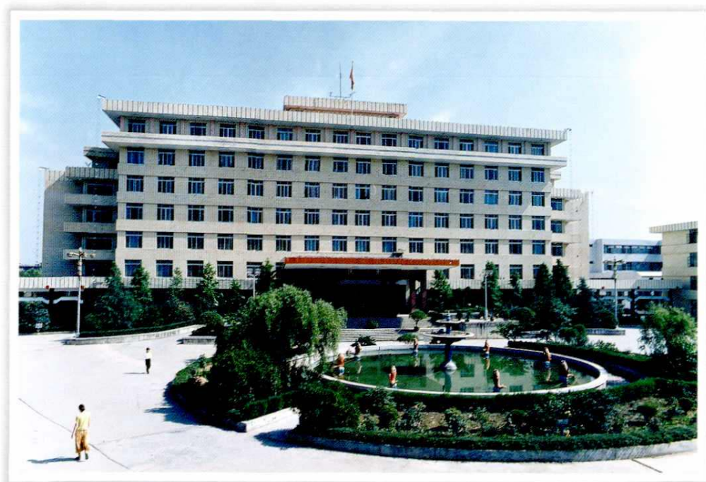
▲ 安康地区行政公署办公大楼
