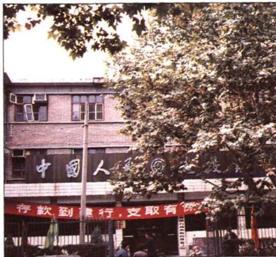
▲ 洛阳市建设银行 王城路办事处
