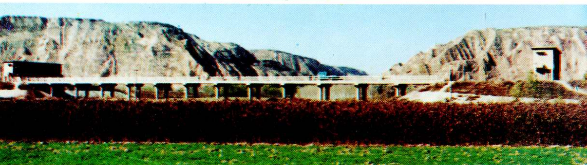
金水倒虹进出 口及公路桥
