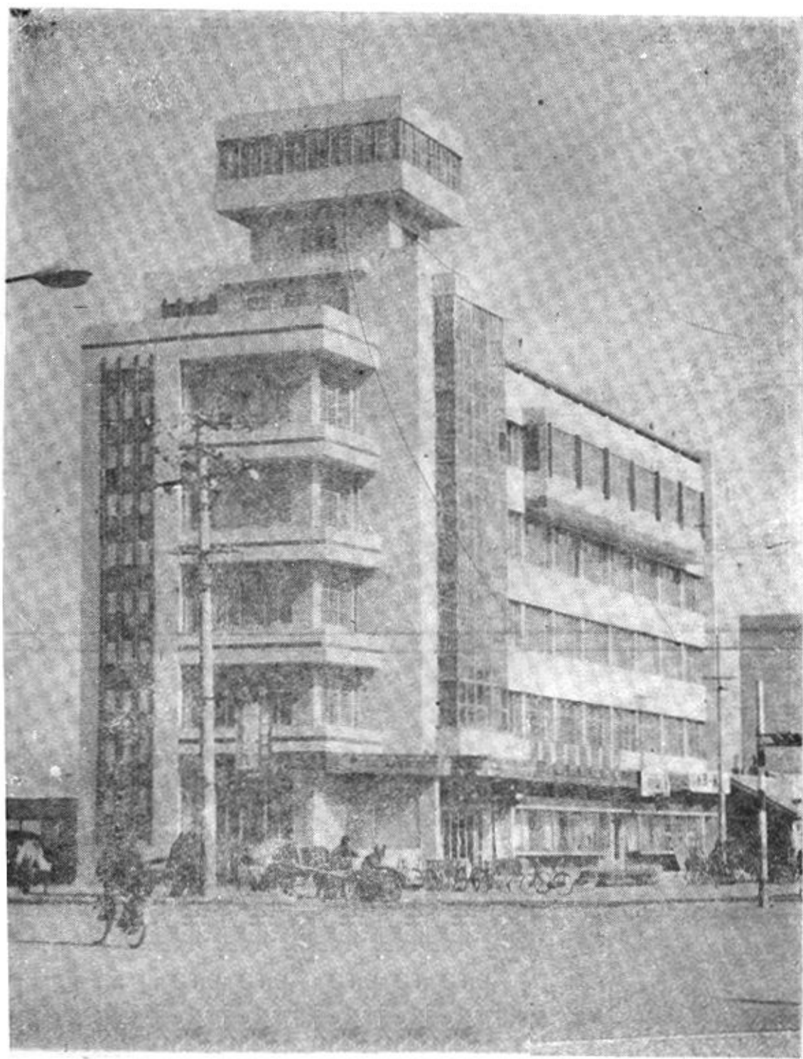
城建局办公楼
