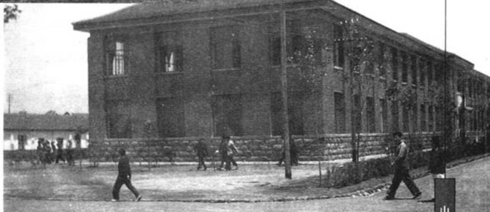
教学二号楼（1952 年竣工）
