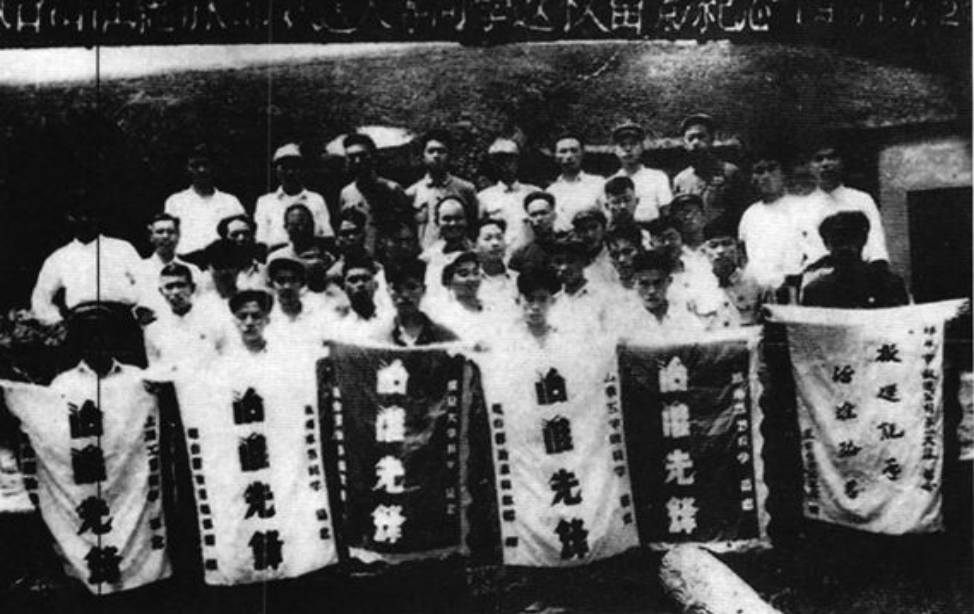
1950年土木系部分师生赴安徽参加治淮工程。前右三举旗者为土木系学生。
