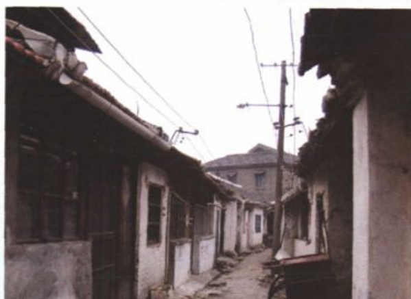
20世纪70年代金沙镇老正街低压线路
