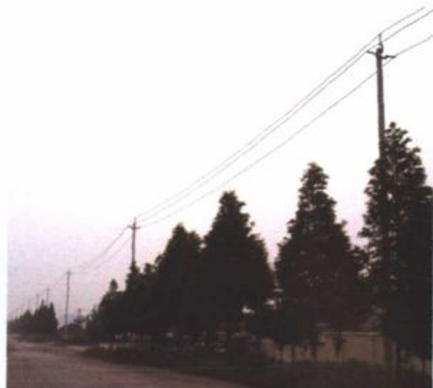
改造后的35千伏通金线金西段
