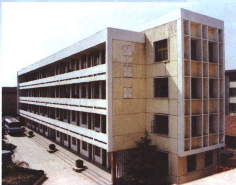
1983年落成的南通县供电局办公楼
