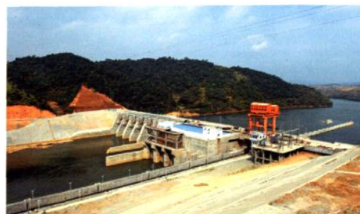
2006年发电投产的右江金鸡滩水利枢纽 (水电站3×2.4万千瓦)
