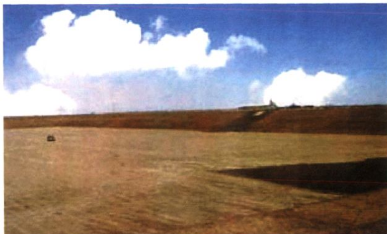
1995年9月，巴基 斯坦乌奇循环联合电厂 蓄水池开挖施工
