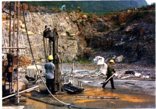
2004年底完工的2×2.5万千瓦龙江下 桥水电站坝基帷幕灌浆
