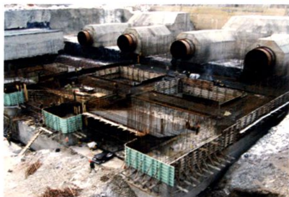
至2006年底基本完成发电机 组尾水肘管机坑外焊接拼装的装机 4×5.31万千瓦的土耳其奥布鲁克 水电站施工现场
