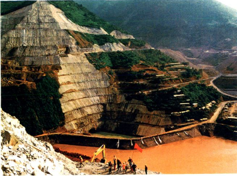
装机总容量 7×70万千瓦的龙 滩水电站右岸导 流洞施工及洞口 高边坡处理，最 大劈坡高度172米
