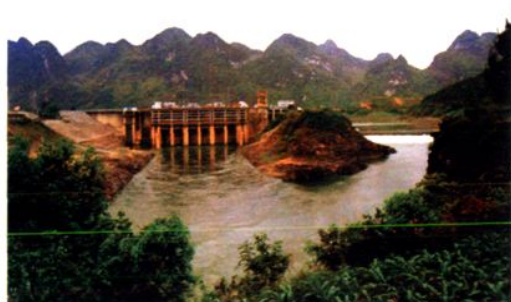
1996年发电投产的红水河百龙滩水电站 (6×3.2万千瓦)
