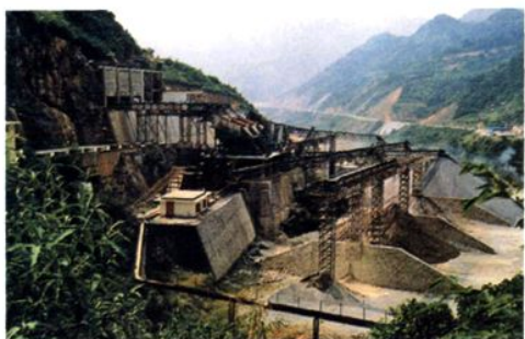
龙滩水电站麻村砂石料生产系统
