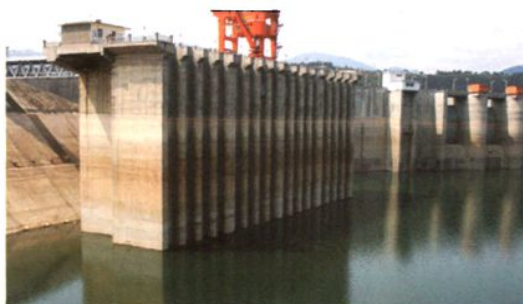
水电站装机总容量 4 \times 13.5 万千瓦的百色水利枢纽地下厂房引水系统进水塔
