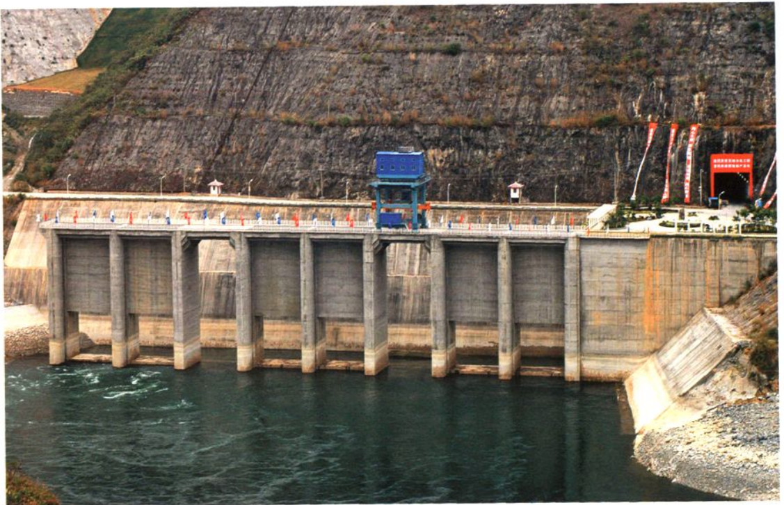
7×70万千瓦龙滩水电站厂房尾水出口工程
