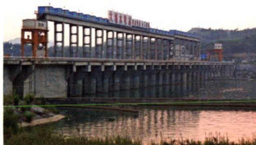
2004年建成投产的融江大埔水利枢纽 (水电站3×3万千瓦)
