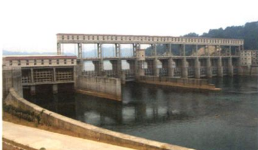
2005年发电投产的桂江下福水利枢纽（水电站 3 \times 1.65 万千瓦）
