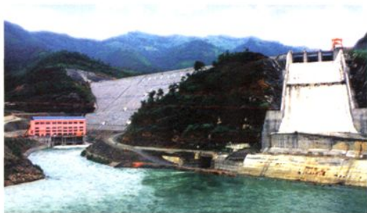
广西首座坝高超过百米的混凝土面板堆石坝，装机容量 3 \times 2.4 万千瓦，2003年2月开工建设、2006年10月首台机组发电投产的百色市西洋江洞巴水电站坝首一瞥。
