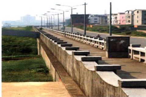
2000年8月竣工的柳州防洪堤一瞥
