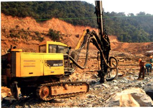
2007年1月，金牛坪水电站二期基坑溢 流坝护坦液压钻在作业
