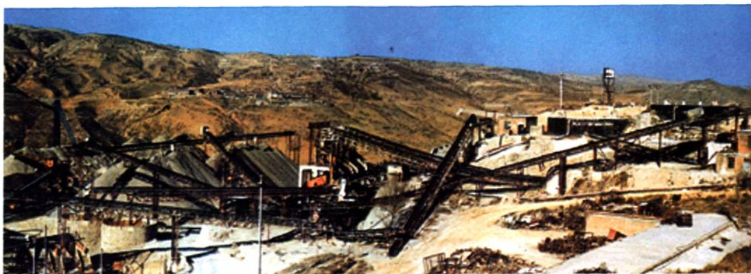
广西水电工程局承建的山西万家寨水利枢纽砂石料生产系统
