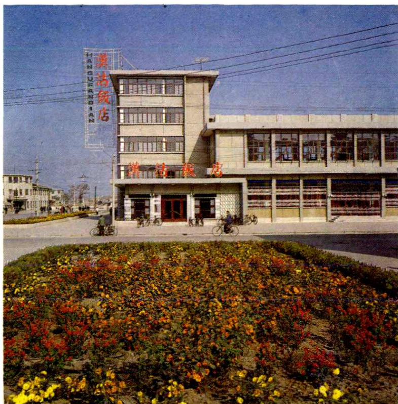
震后重建的汉沽饭店
