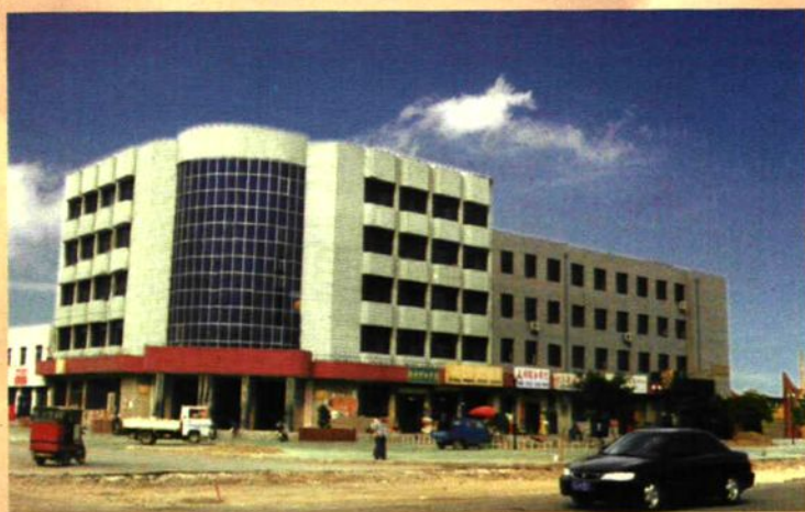
隆湖开发区管委会办公大楼
