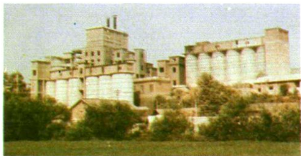
▲ 攸县网岭水泥厂生产区一角
