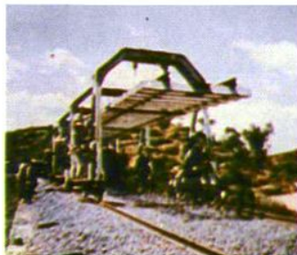
► 株洲桥梁工厂生产的 轨枕在湘桂线上铺设
