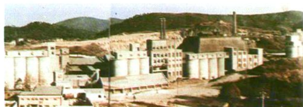
▲株洲市平山矿水泥厂 4.4 万吨生产线全貌
