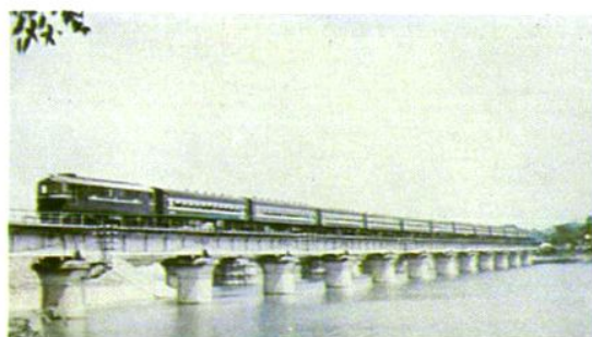
▲株洲桥梁工厂生产的铁路桥梁架设的 岳阳新墙河大桥
