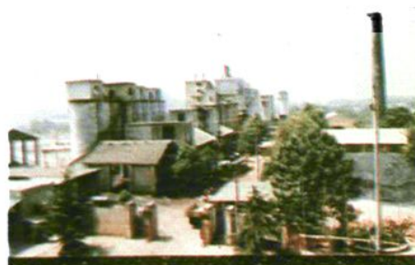
▲株洲市郊区水泥厂全貌
