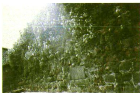
▲公元 1228 年建造的茶陵城墙一隅
