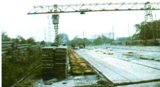
▲市建筑材料厂混凝土 预制场一角
