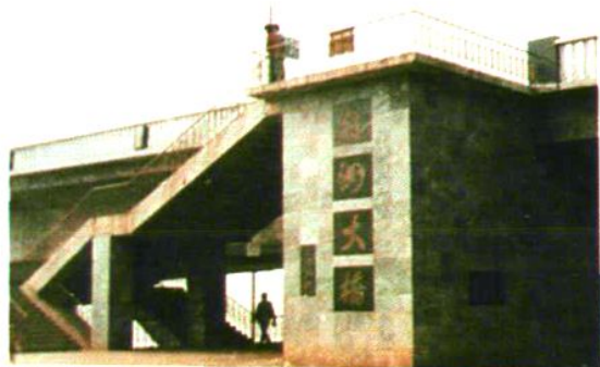
▲用株洲市水泥厂生产的 水泥建造的株洲湘江大 桥桥头
