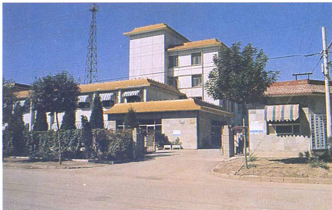
津南区工商行政管理局办公楼外景。
