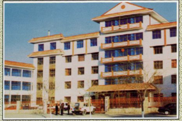
▲ 武威市(县级)人民检察院办公楼
