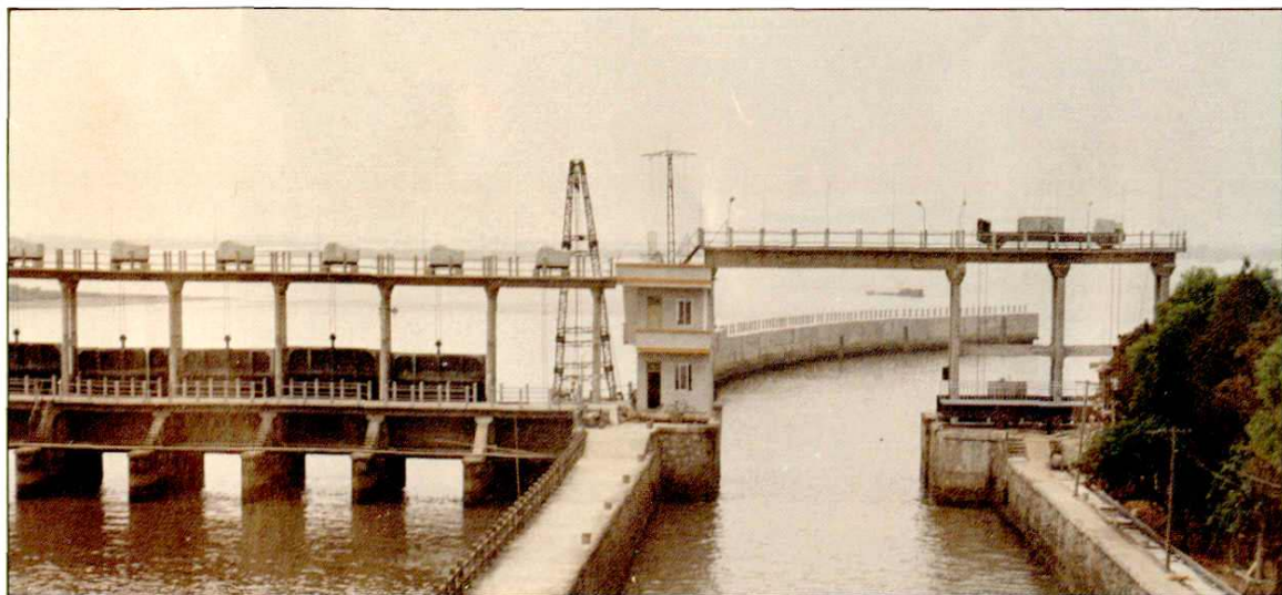
西河船闸及一九九二年改建后的导航墙。
