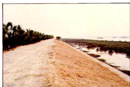
加固后的新围堤段。
