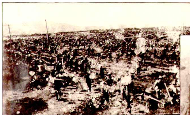
当年西河口水闸施工现场一角。
