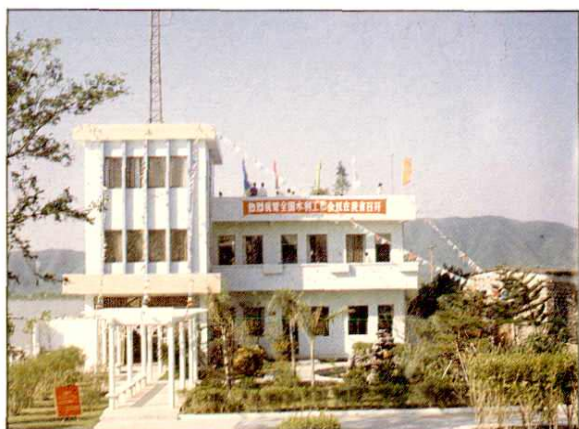
西河口水闸管理室。
