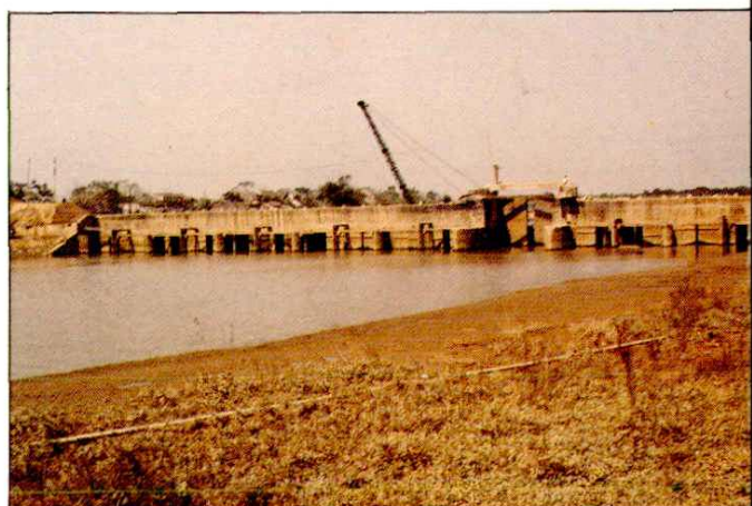
加固前的拱北水闸。
