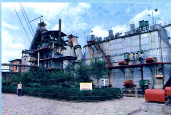
▲银山磷肥厂8万吨级单系统硫酸生产装置
