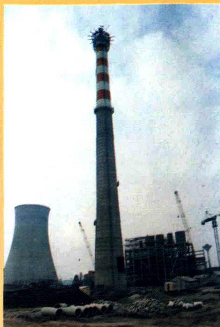
▲在建中的循环流化床锅炉示范装置
