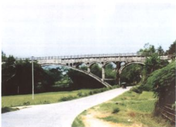
茂化水库灌区扶新渡槽
