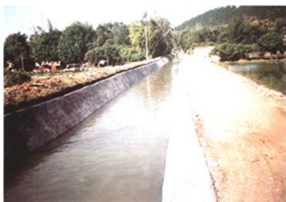
三面光硬化渠道
