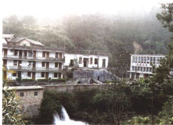
北流的第一座水电站——龙门电站
