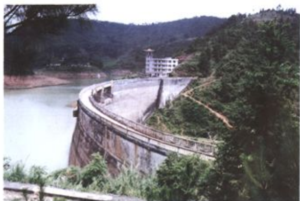
大村双曲拱坝
