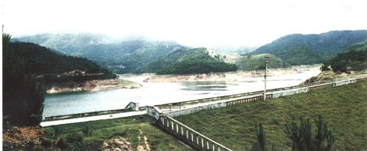
大容山电站高垌水库
