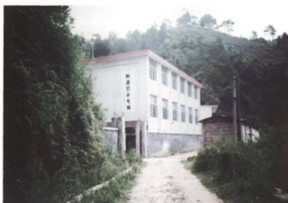
桃源引水电站
