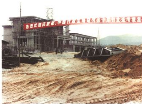
施工中的圭江水利枢纽
