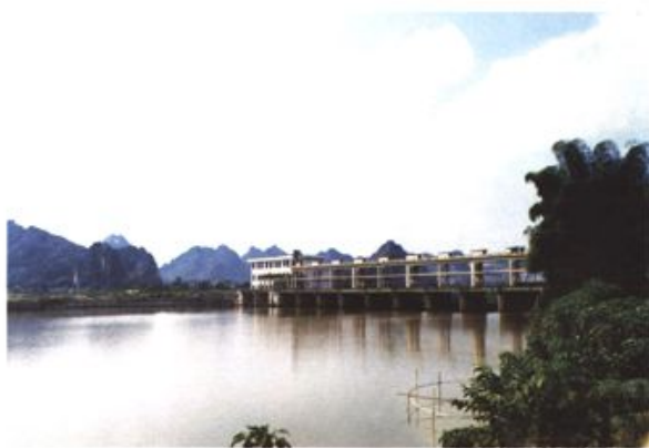
圭江水利枢纽工程
