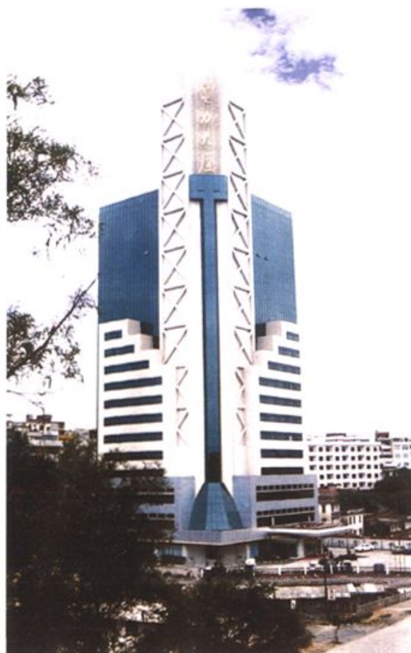
北流电力大厦
