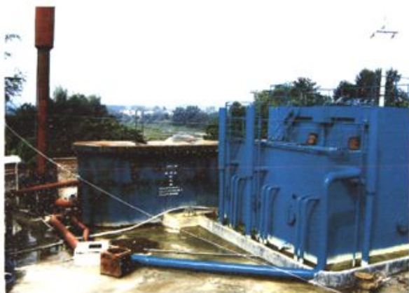
十字铺兵营水厂
