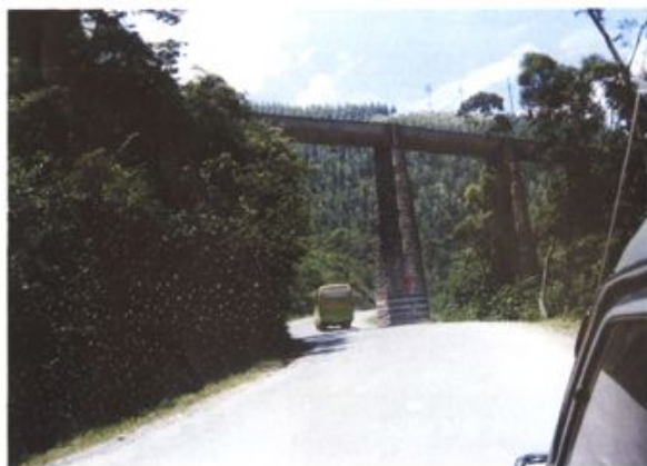
蟠龙灌区渡槽
