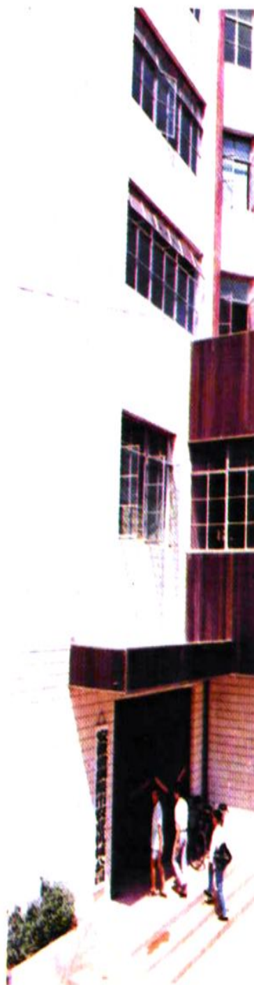
市农机公司办公楼
