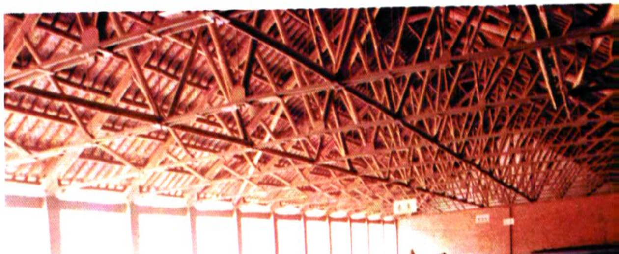
市金属材料公司钢材仓库一角
