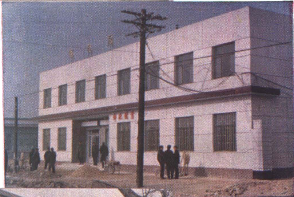
▶邮电支局现局址 (1991年竣工)
