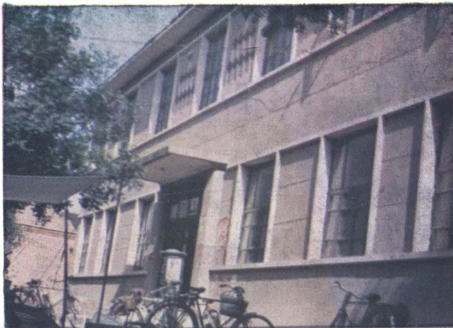
邮电支局营业办 公楼(1981年竣工)▶
