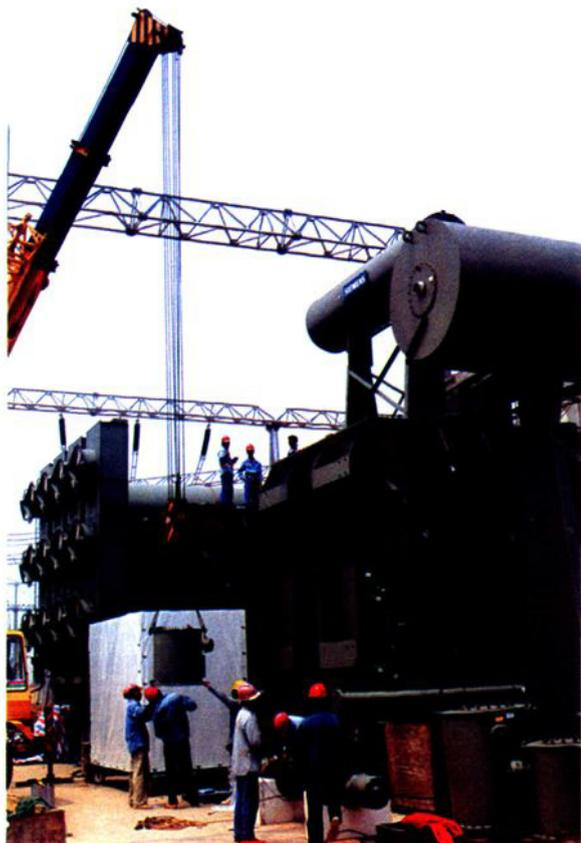
2000年7月500千伏北郊直流站吊装主变压器
