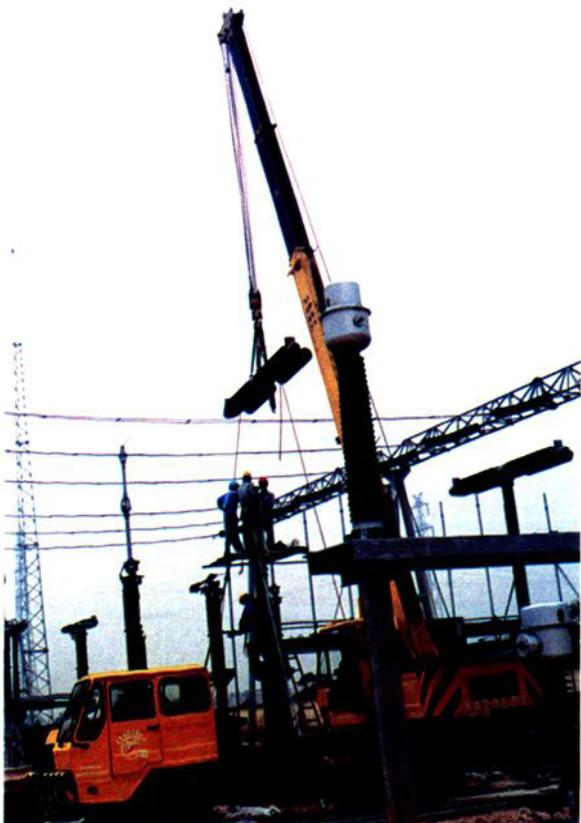
1999年公司施工500千伏北郊变电站吊装断路器
