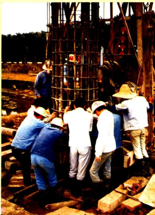
线路灌注桩基础施工
