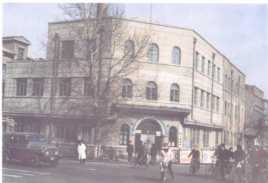
长春市煤气公司煤 气管理处办公楼
