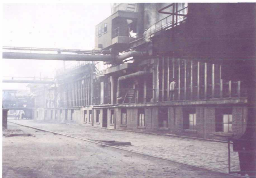
长春市煤气公司站前 煤气厂“六六型”焦炉机侧
