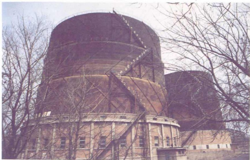
长春市煤气公司煤 气管理处南岭贮气罐
