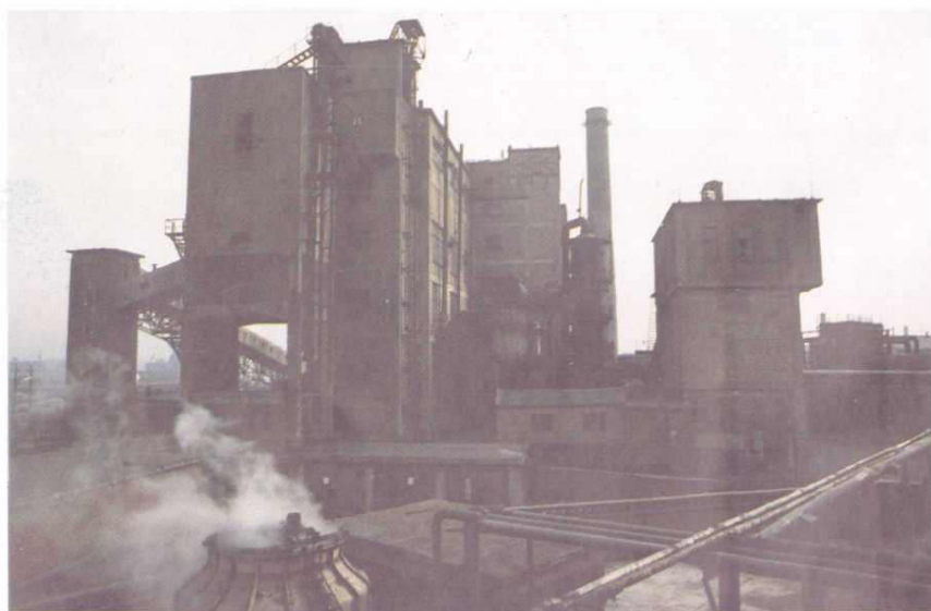
长春市煤气公司站前 煤气厂直立炉
