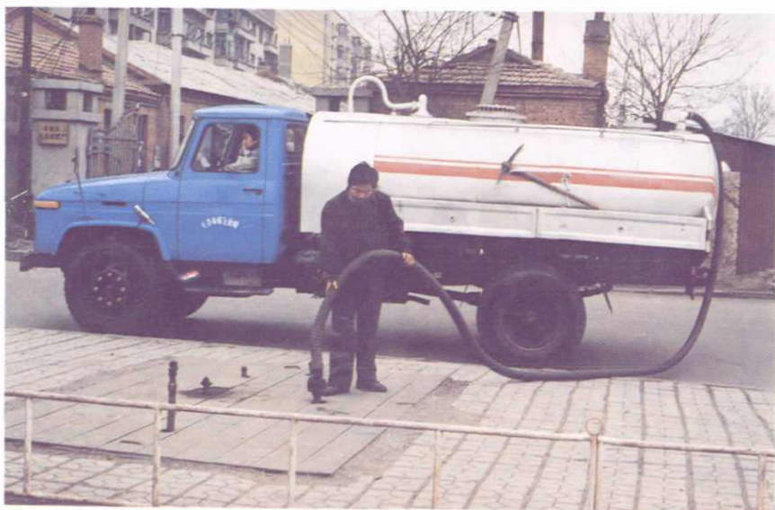
长春市煤气公司煤 气管理处煤气抽水车在 抽水作业
