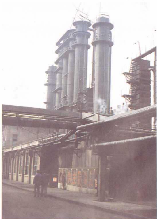
长春市煤气公司站前煤气厂第五净化室全貌
