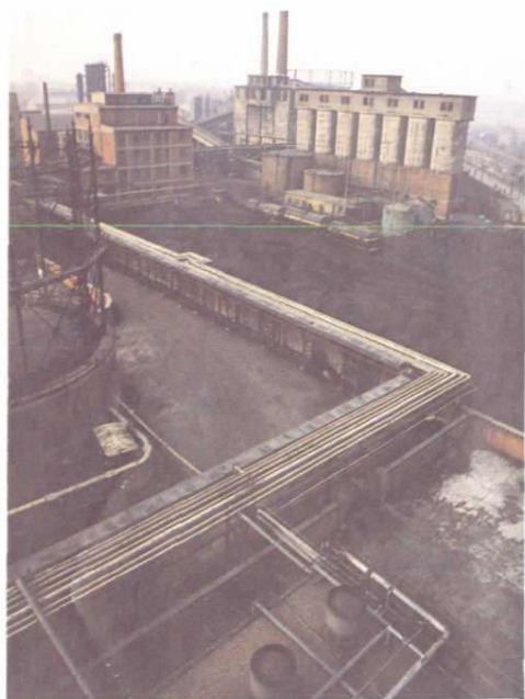
长春市煤气公司站前煤气厂备煤场一角
