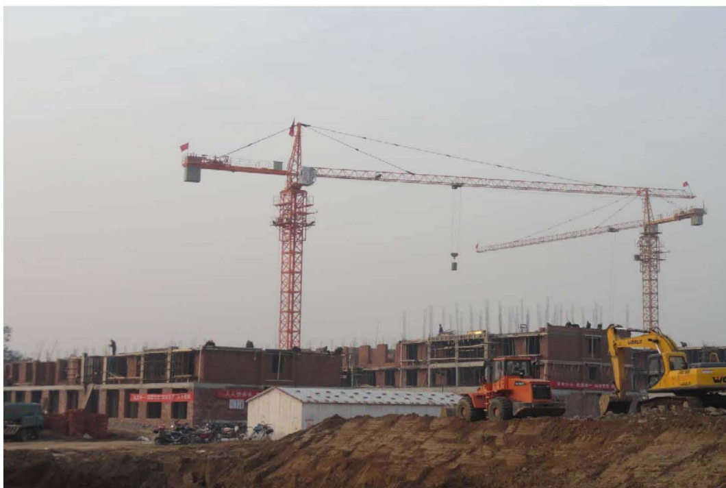
建设中的“翰林官邸”小区
